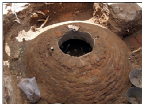
Aljibe durante su descubrimiento. La bóveda tiene una geometría muy regular
