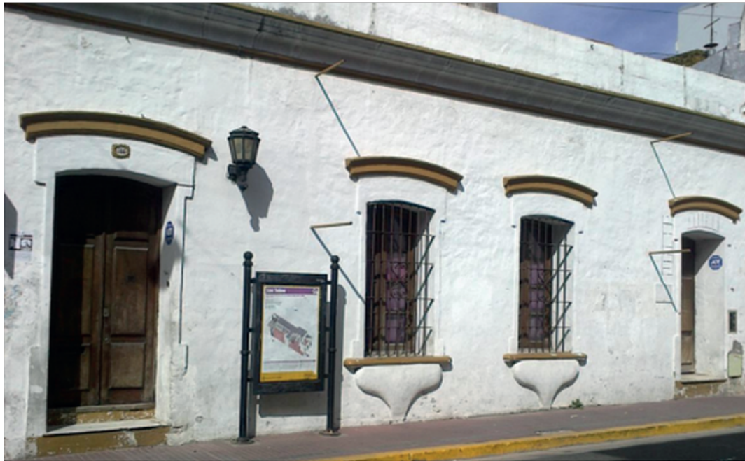
Fachada del inmueble situado en Defensa 1344, Ciudad Autónoma de Buenos Aires
