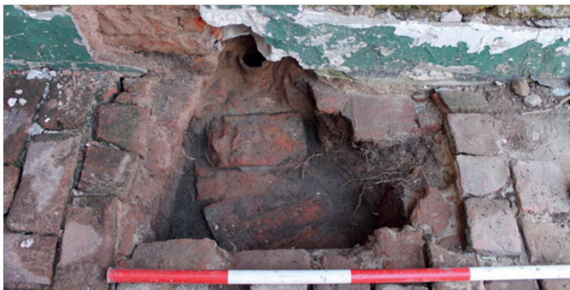
Desagüe de hierro como bajada pluvial que se conecta con los desagües horizontales de ladrillo
